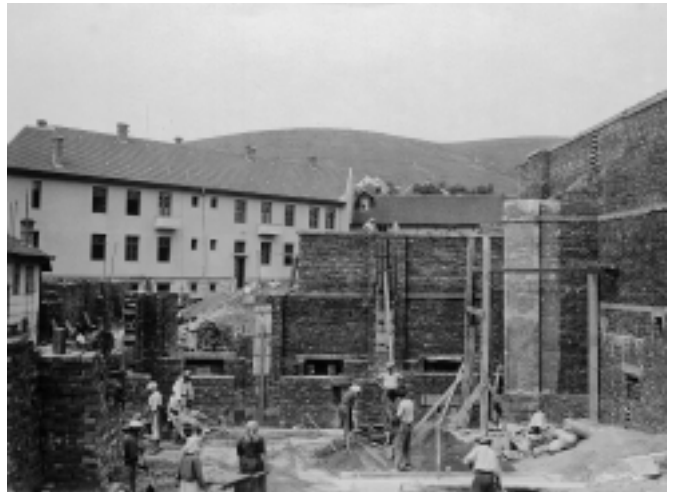
Baustelle des großen Saals, dahinter das 1934 fertiggestellte Gebäude
